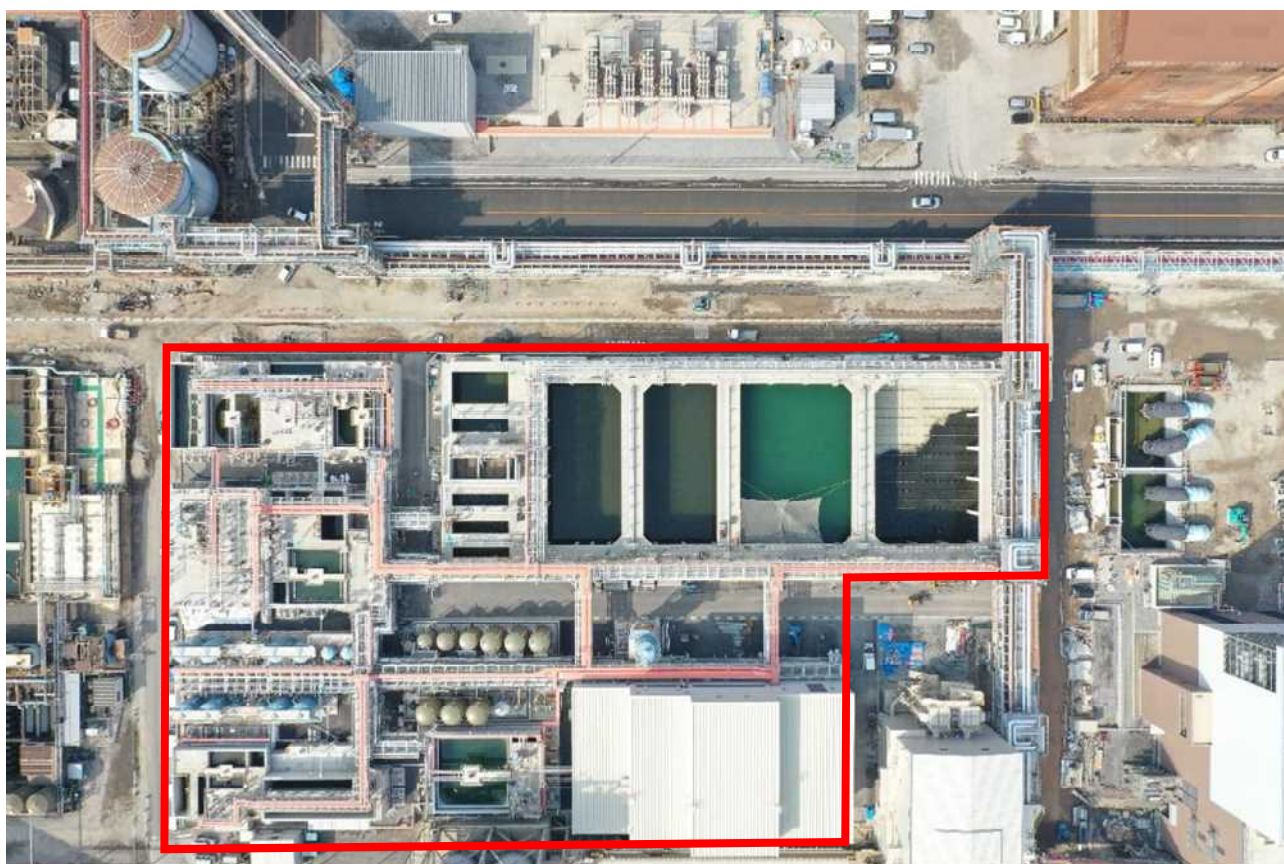
写真 5.2-1 総合排水処理設備（新設）の設置状況
