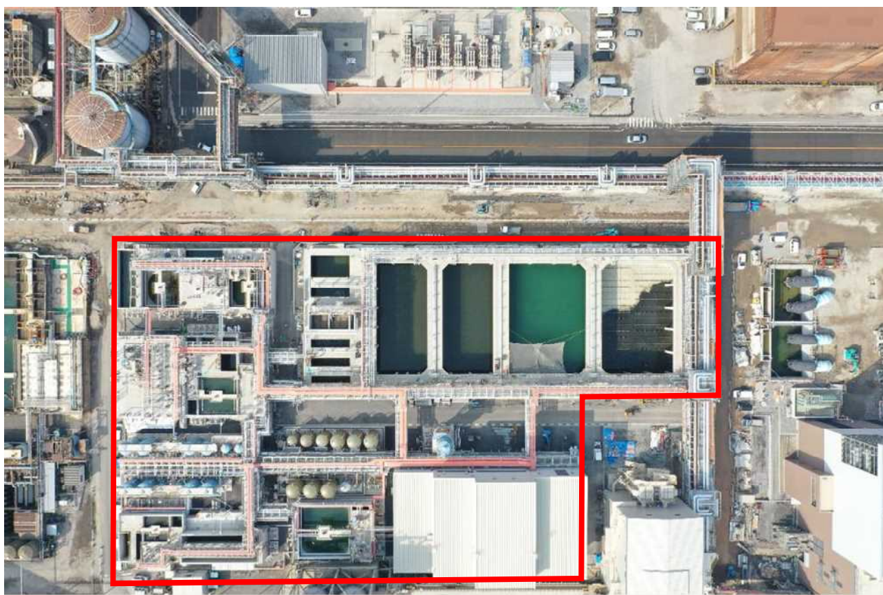
写真 5.2-1 総合排水処理設備（新設）の設置状況
