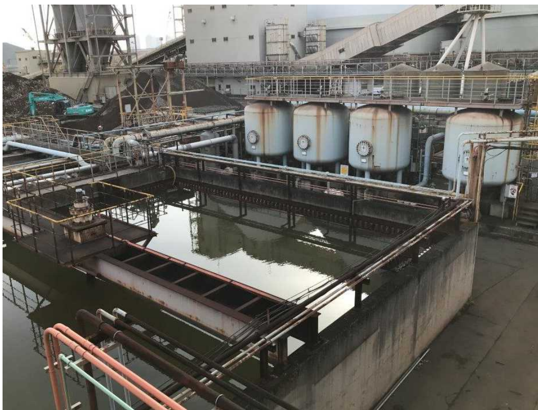
写真 4. 2-1 工事排水処理設備の設置状況
