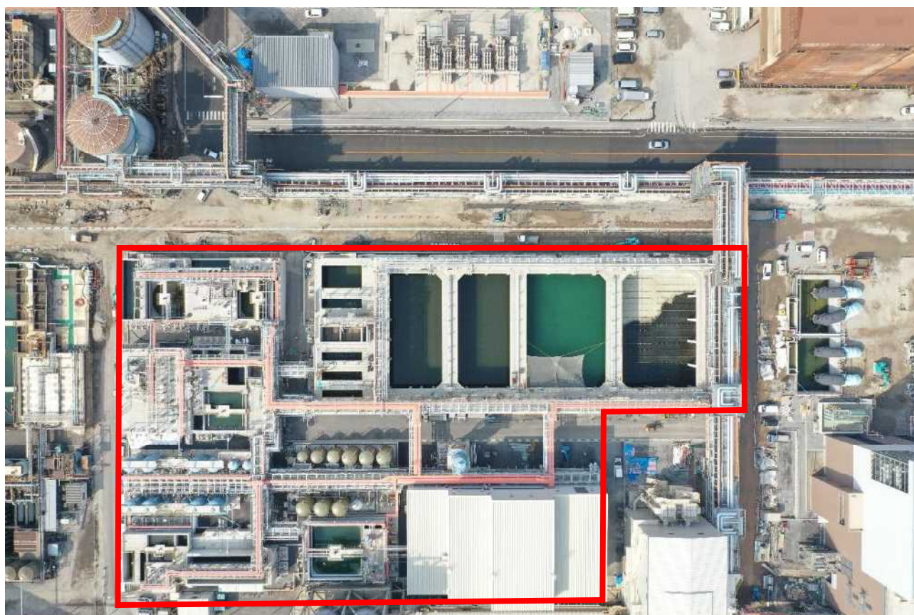
写真 4.3-1 総合排水処理設備（新設）の設置状況
