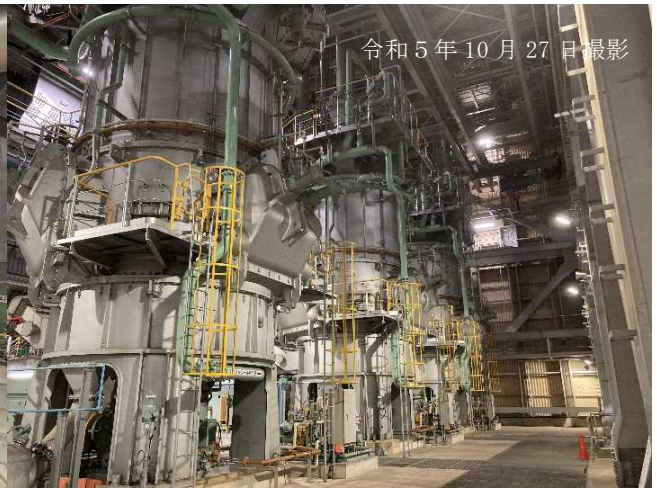
写真 4.2-1(2) 騒音発生機器、振動発生機器及び低周波音発生機器の状況 (左図：押込通風機の強固な基礎上の設置、右図：微粉炭機の強固な基礎上の設置)
