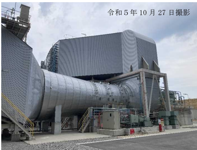
写真 4.2-1(3) 騒音発生機器、振動発生機器及び低周波音発生機器の状況 (脱硫通風機の防音カバー、強固な基礎上の設置)
