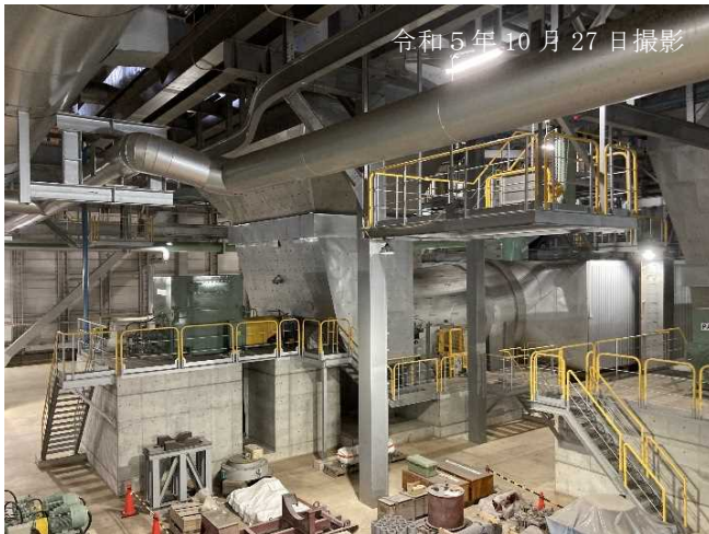
写真 4.2-1(2) 騒音発生機器、振動発生機器及び低周波音発生機器の状況 (左図：押込通風機の強固な基礎上の設置、右図：微粉炭機の強固な基礎上の設置)
