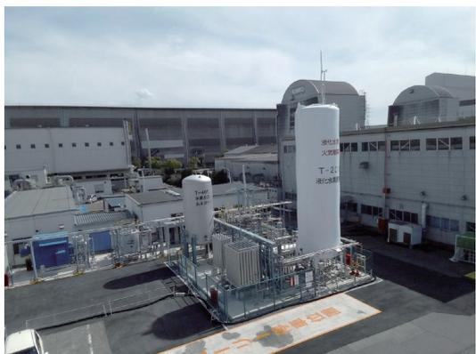
図4 LH<sub>2</sub>気化実証設備の全景
