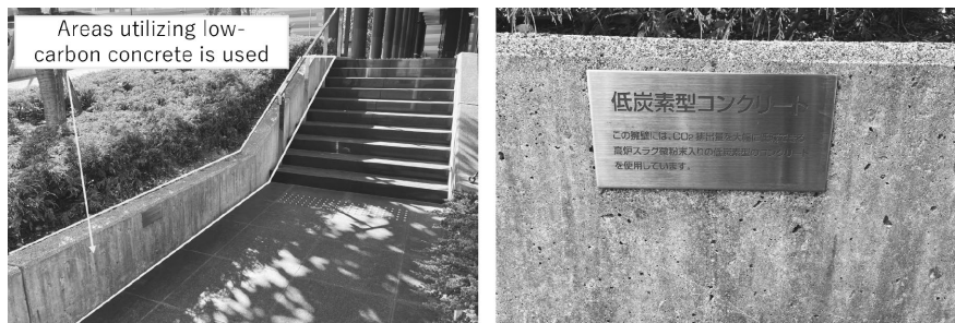
図1 神戸製鋼所神戸本社の社屋擁壁に使用された低炭素型コンクリート Fig.1 Low carbon type concrete utilized in the retaining wall at Kobe head office of Kobe Steel
