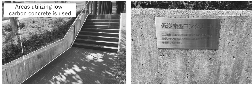
図1 神戸製鋼所神戸本社の社屋擁壁に使用された低炭素型コンクリート Fig.1 Low carbon type concrete utilized in the retaining wall at Kobe head office of Kobe Steel
