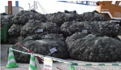
潜堤構築材（中詰材：鉄鋼スラグ水和固化体）
