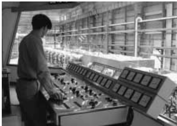
写真 2 運転操作室 Photo.2 Operating pulpit
