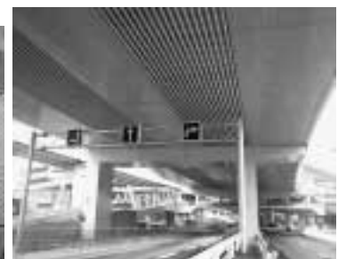
写真2 高架高速道路裏面吸音板の施工状況
