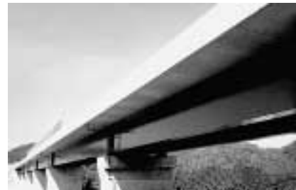
写真1 上信越自動車道 儀明川橋(2主桁橋)
