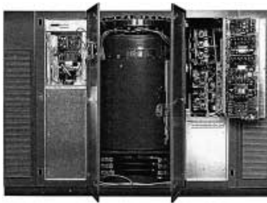
写真 1 無停電電源システムの外観
