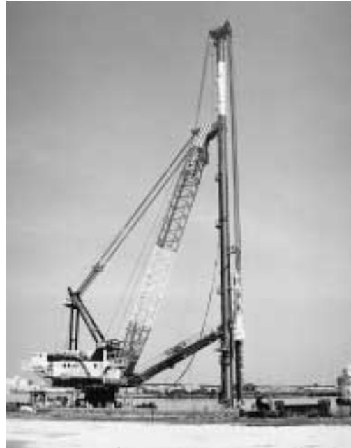
写真 1 F&G3545 クレーン・グラブ兼用船の外観
