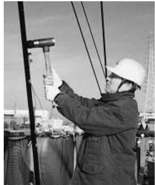
写真2 ケーブル打撃 Photo 2 Hammering
