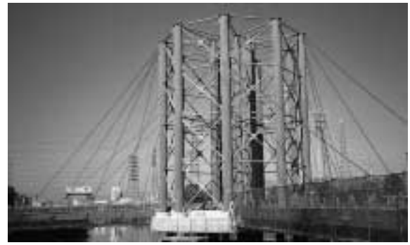
写真1 斜張橋の外観 Photo 1 Cable-stayed bridge
