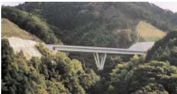
写真1 竹花第三橋の全景
