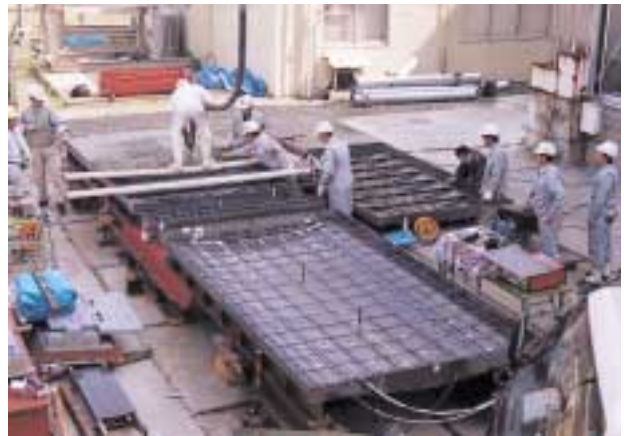
写真1 打設試験の状況 Photo 1 Casting test
