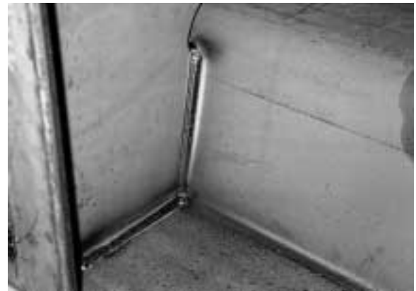
写真6 溶接ロボットの溶接ビード Photo 6 Weld bead of arc welding robot
