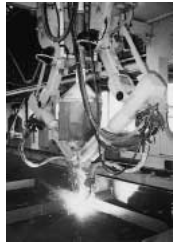
写真2 ロボット溶接例 Photo 2 Example of arc welding by robots
