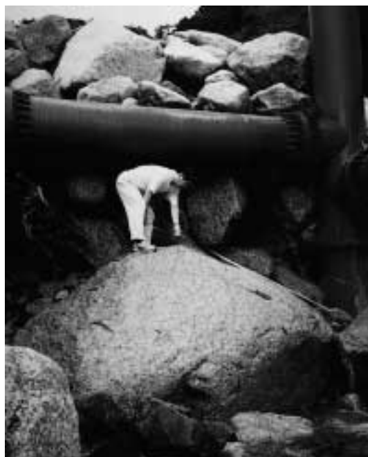
写真2 開口部で捕捉された礫（大柵沢第2砂防ダム） Photo 2 The rocks trapped at the space between the pipes (The second dam in Ohtanazawa)
