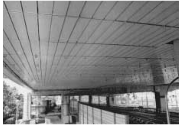
写真3 高架高速道路での施工例
