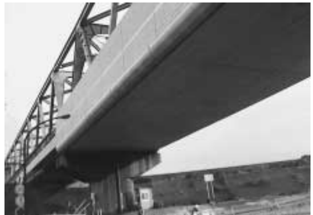
写真4 鉄道橋での施工例
