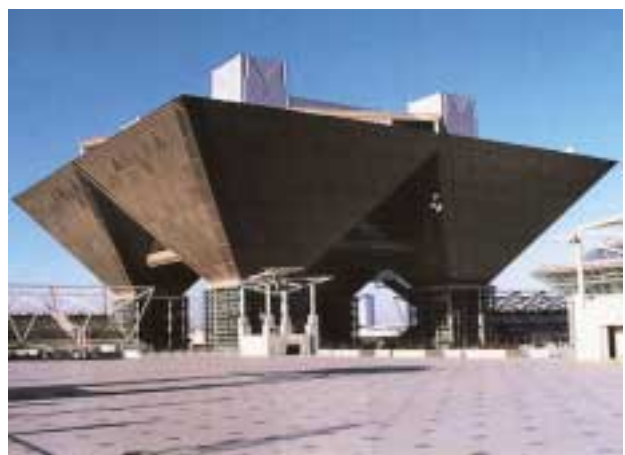
写真3 東京ビッグサイト/チタン外壁 Photo 3 Tokyo Big Sight/titanium wall
