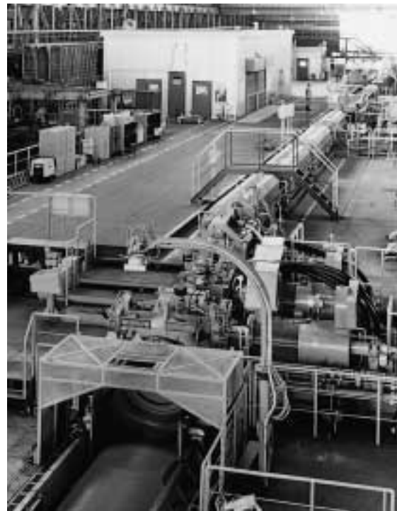
写真3 新レイングヘッド周辺 Photo 3 New laying head
