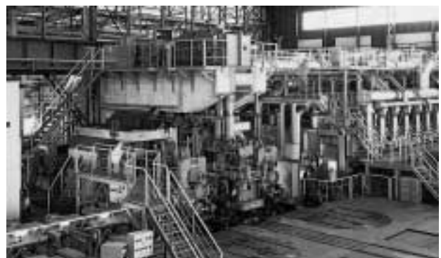
写真4 新加熱炉と鋼片圧延機
