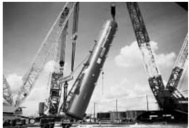
写真 1 クラーク社向 2・1/4Cr-1Mo-V 改良鋼製リアクタ
