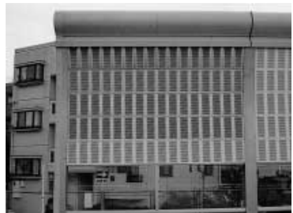
写真 3 実証試験用のアルミ製道路用遮音壁(水ガラス系 2 層構造型低汚染塗膜を塗工)
