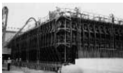
写真1 アルミ製大型ユニット式システム型枠
