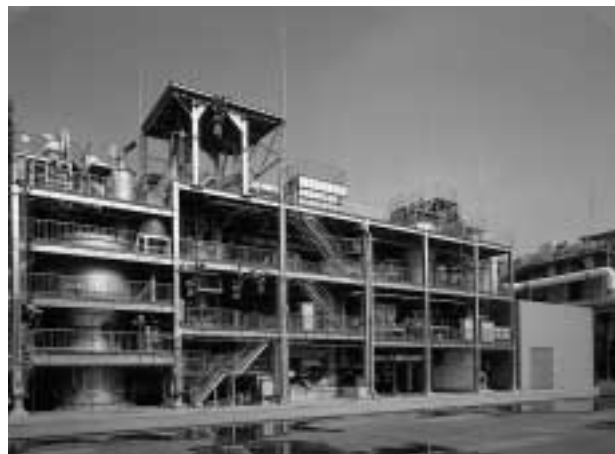
写真2 120ton/day 下水汚泥熱分解+溶融プラント全景 Photo 2 Appearance of 120ton/day sewage sludge melting plant
