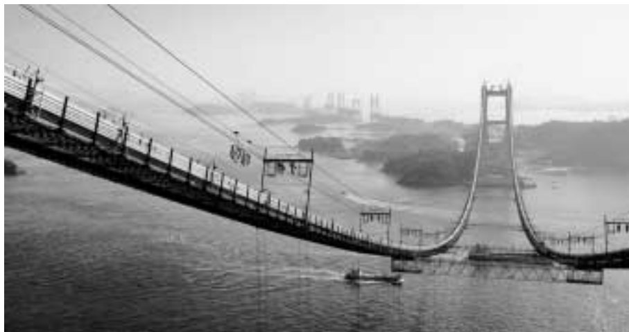
写真5 低張力AS工法による下津井瀬戸大橋のケーブル架設状況 Photo 5 Air spinning under low wire tension at the Shimotui-Seto Bridge
