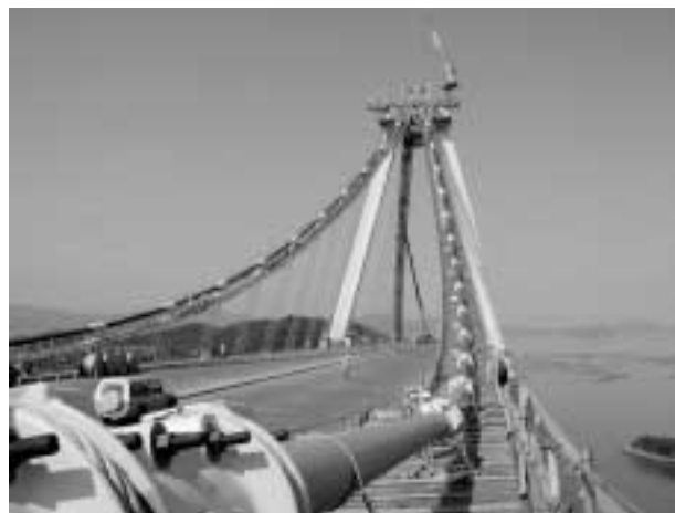
写真6 韓国ヨンジョン大橋の架設状況
