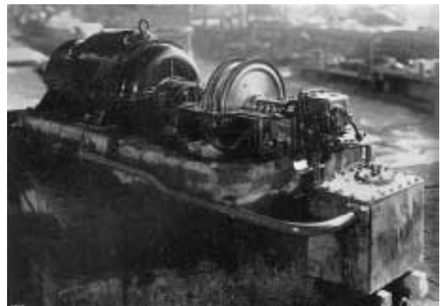
写真 3 最初の膨張タービン Photo 3 Our first turbo-expander delivered in 1936
