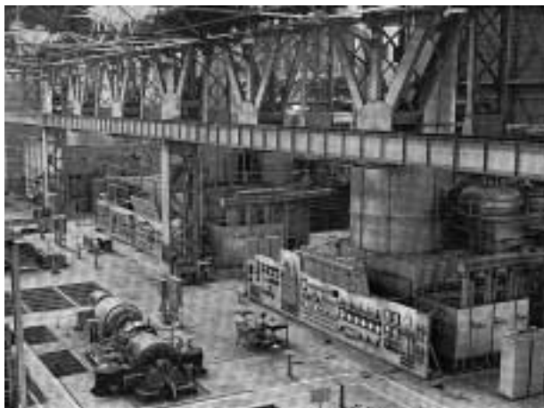
写真4 製鋼用酸素製造装置 Photo 4 Oxygen plant for steel making
