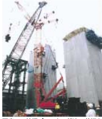
写真3 鑄鋼ブロックの組込み状況と完成状況
