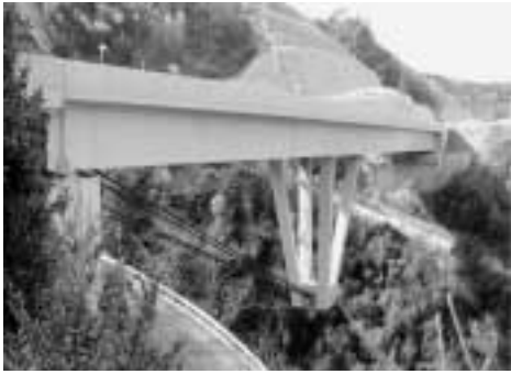
写真1 ケーブルトラス橋(竹花橋) Photo 1 Cable trussed bridge (The Takehana Bridge)
