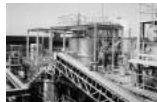
写真1 滋賀県湖南中部浄化センター循環流動層下水汚泥焼却設備 36t-ケーキ/日 (し渣1.7t/日)
