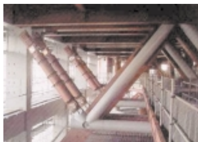
b) 仕口鋳鋼品取付け状況 b) Erection of cast steel node
