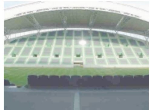
e) 神戸ウイングスタジアム完成状況 e) Erection of Kobe-wing Stadium
