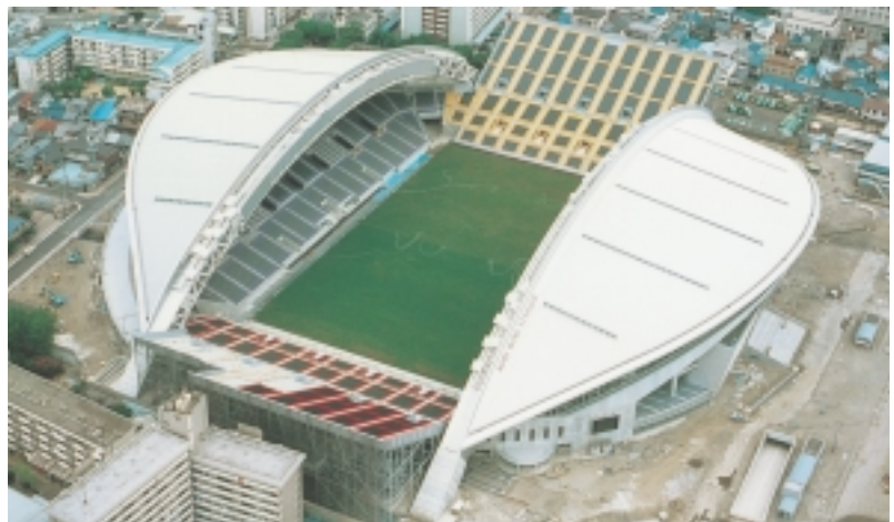
写真1 1次整備段階の神戸ウイングスタジアム Photo 1 Primary constructed state of the stadium
