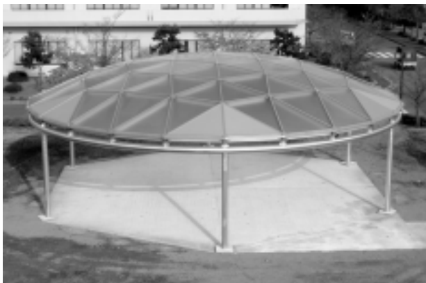
写真1 ドーム型アルミトラス構造 Photo 1 Dome type aluminum truss structure
