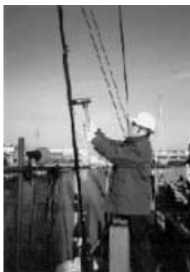
写真2 振動法によるケーブル張力測定 Photo 2 Measurement of cable tension by vibration method
