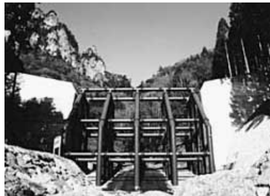
写真4 格子型鋼製堰堤 Photo 4 Steel grid sabo dam
