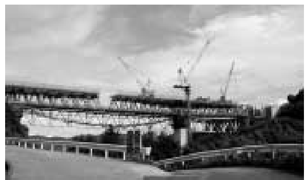
写真5 バランストカンチレバー工法 Photo 5 Balanced cantilever erection method
