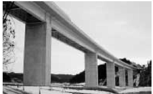
写真1 鯉川橋 Photo 1 The Koikawa Bridge
