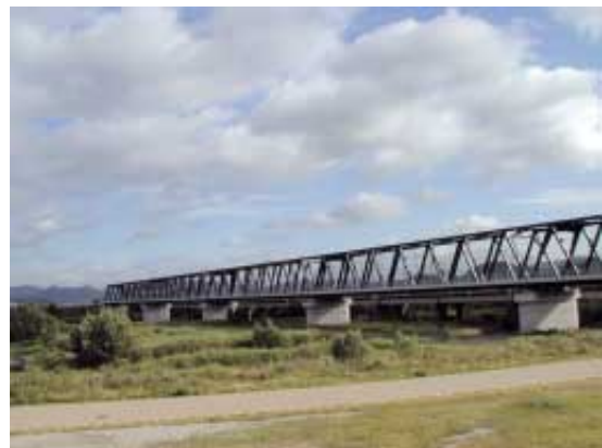
写真4 加古川橋梁 (スーパータイコール W)
