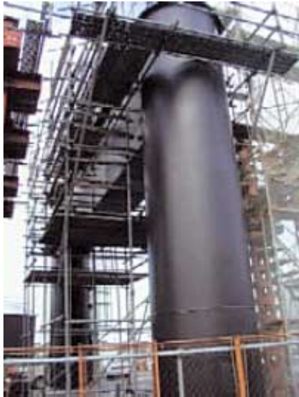
写真5 観法寺橋脚（スーパータイコールW） Photo 5 The Kanpouji Steel Piers (Super-ticor W)
