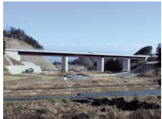
写真7 上池橋（エコビュー） Photo 7 The Kamiike Bridge (Eco View)
