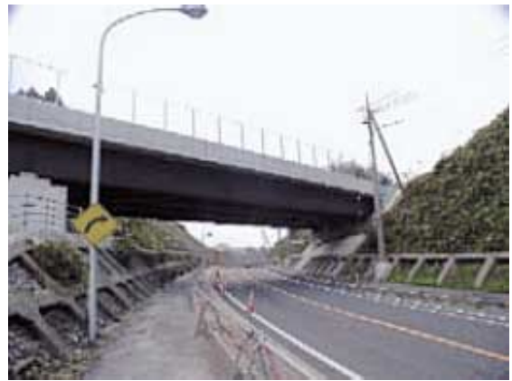
写真6 園跨線橋（スーパータイコールW） Photo 6 The Sono Over Bridge (Super-ticor W)
