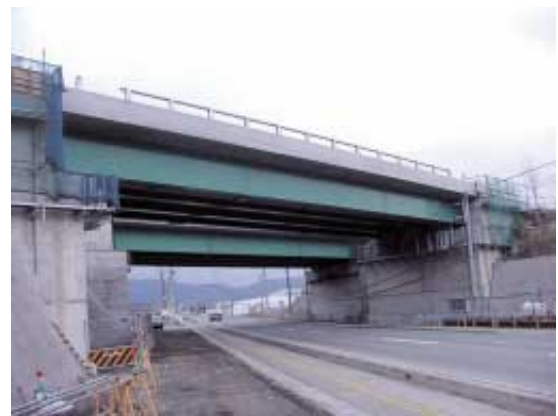
写真8 有明橋（エコビュー） Photo 8 The Ariake Over Bridge (Eco View)
