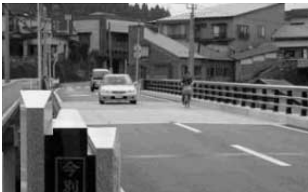
写真2 今別橋の車両走行 Photo 2 Vehicles running over the Imabetu Bridge
