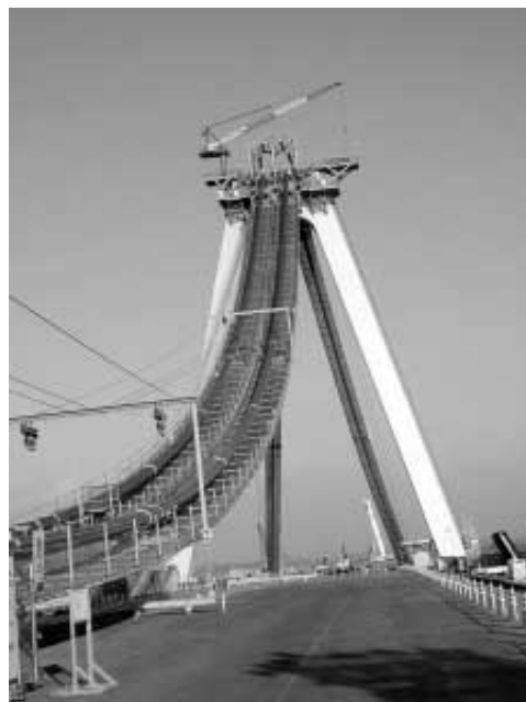
写真3 ピアスピニング完了状況 Photo 3 After aerial spinning
