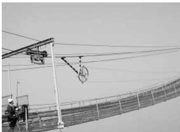
写真2 ワイヤ架線状況 Photo 2 Aerial spinning
