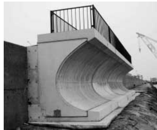
写真1 フレア護岸の試験設置例
