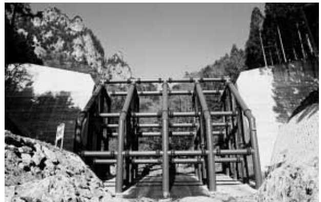
写真1 格子形堰堤 Photo 1 Steel grid dam
