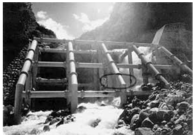
写真3 南股第4砂防堰堤 Photo 3 The Minamimata No.4 sabo dam
