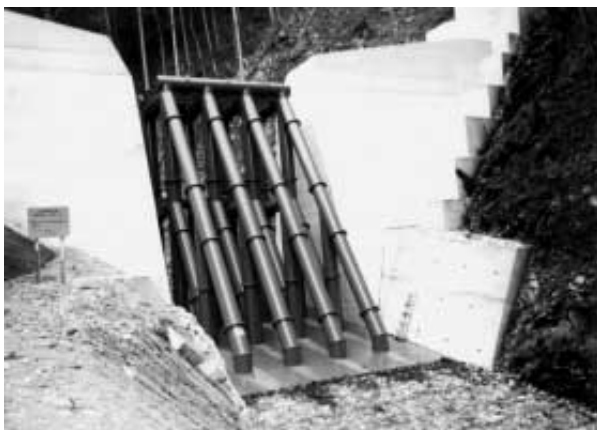
写真2 格子形-2000C Photo 2 Steel grid dam -2000C
