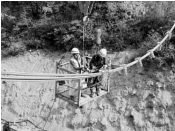
写真5 バンド取付け Photo 5 Installation of attachments
