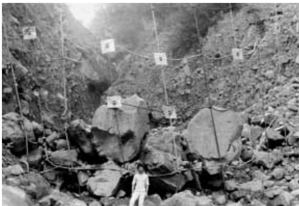
写真1 従来式ワイヤネット工による土石流の捕捉状況 Photo 1 Debris flow caught by former wire net dam
