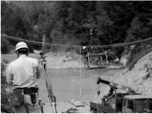
写真4 サグ調整 Photo 4 Sag adjustment
