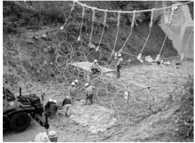
写真6 リングネット形状調整 Photo 6 Arrangement of ring nets
