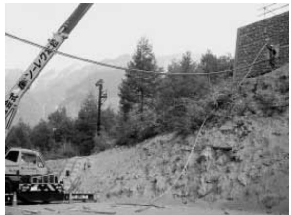
写真3 ケーブル架設 Photo 3 Erection of main cable
