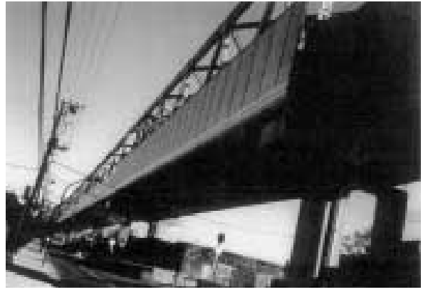
写真14 桁カバー（鉄道橋） Photo 14 Soundproof covering for railroad bridge
