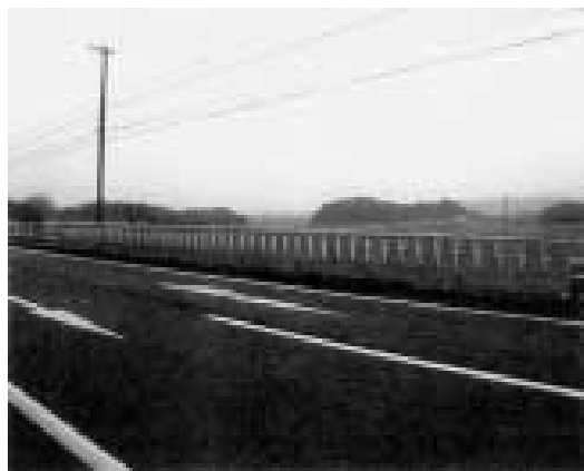
写真11 低層山形消音装置（歩車道分離） Photo 11 Low mountain shaped noise barrier to separate sidewalk
