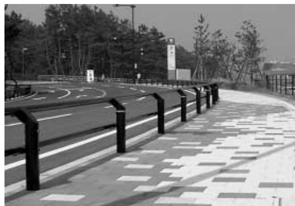
写真1 TMS型防護柵の施工例
