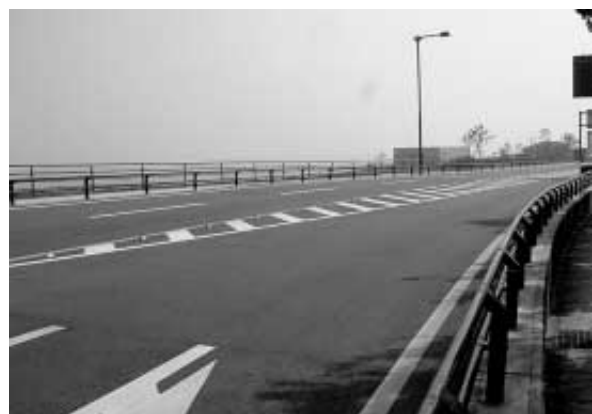
写真2 TMS型防護柵の施工例
