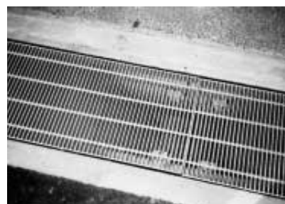
写真3 アマグレフィット施工例
