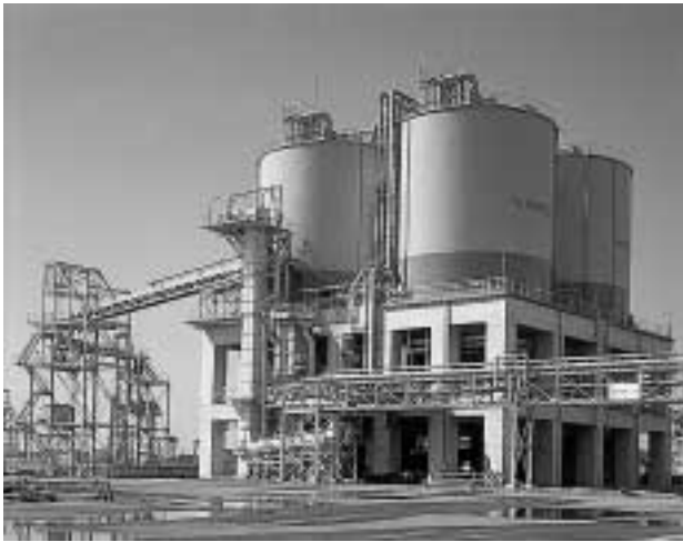
写真4 石炭灰サイロ Photo 4 Ash silos
