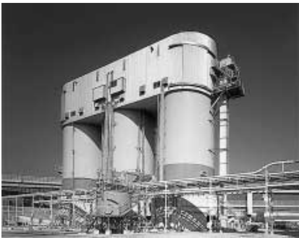
写真5 石こうサイロ Photo 5 Gypsum silos
