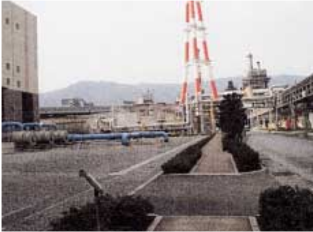
写真3 舗装の外観（神鋼神戸発電所構内）
