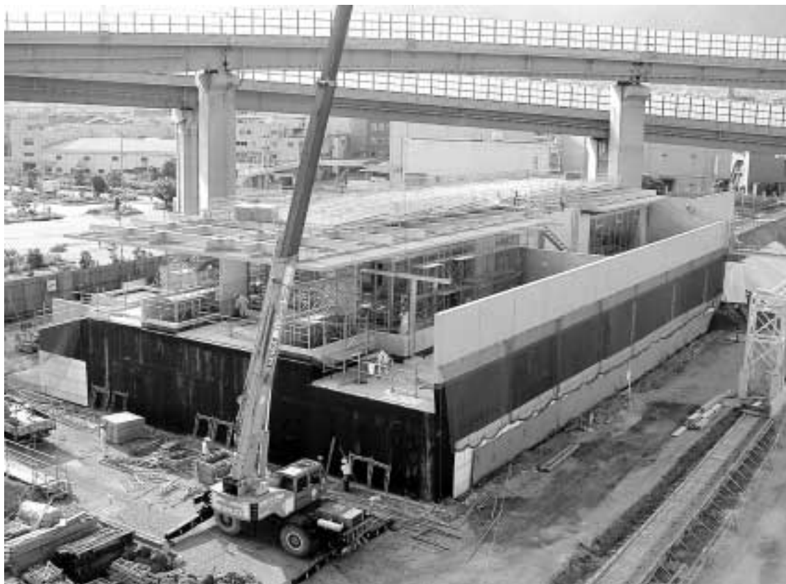
写真1 外装工事中のエネルギー資料館 Photo 1 Energy Shiriyokan under exterior work
