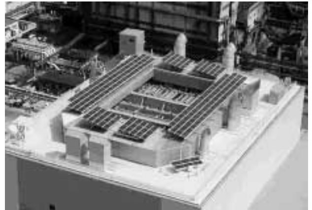
写真5 IPP 1号機ボイラ建屋 Photo 5 IPP boiler #1
