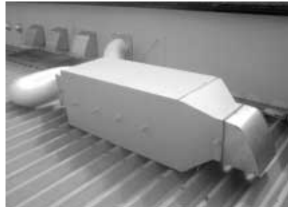
写真2 実排ガス脱臭試験装置(とんかつ店) Photo 2 Field test equipment for tonkatsu fryer exhaust
